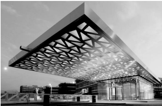
Fassadenbau Beispiel: TRUMPF Empfang
